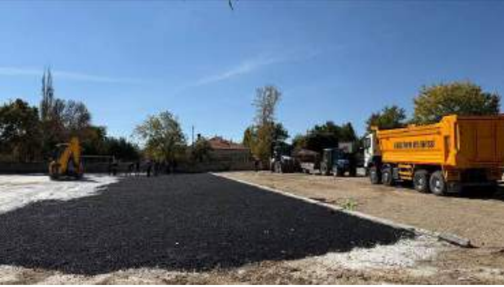
Öğrencilerimizin daha konforlu bir alanda vakit geçirebilmeleri için Şehit Tunahan Erbaş İlkokulu bahçesinde sıcak asfalt çalışmaları
